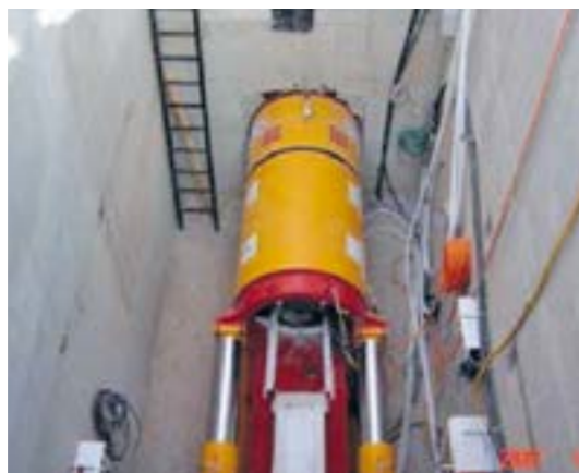
Щит TBM 1200 в стартовой шахте в Медине
