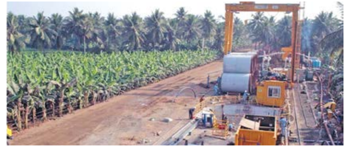
Оборудование строительной площадки, на которой будет использоваться комбинированный щит. Индия, проект пересечения реки Годавари
